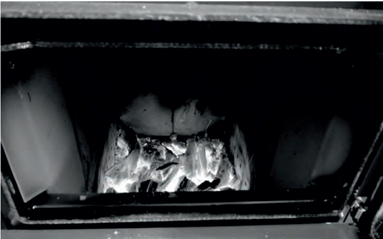
Bild 13. Die Höhe der Glut, die zum Nachlegen geeignet ist.
