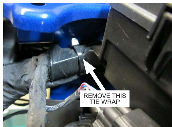
Fig. 4-i: Remove Harness Tie Wrap
