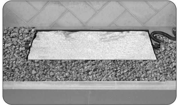
Fig. 12-1 Place sand/vermiculite
