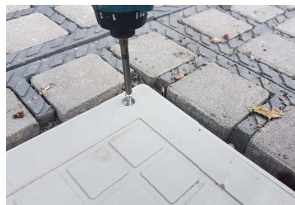
Fixierung befahrbare Abdeckung
