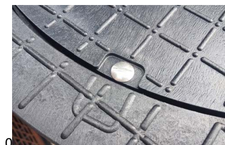
Teleskopschachtabdeckung mit Verschraubung von oben
