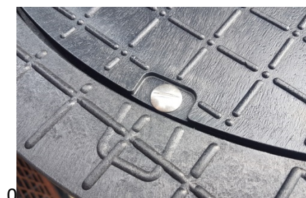
Teleskopschachtabdeckung mit Verschraubung von oben
