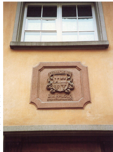
Rechts: Das steinerne Rausch-Familienwappen über dem Eingang des Fabrikgebäudes an der Konstanzerstrasse 54 in Emmishofen.
