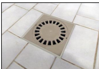
Doucheplug bevestigd met SABA Wellfix
