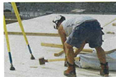
Abbildung 3: Befestigung der X-fix C Verbindung mithilfe eines Schonhammers/Schonschlegels
