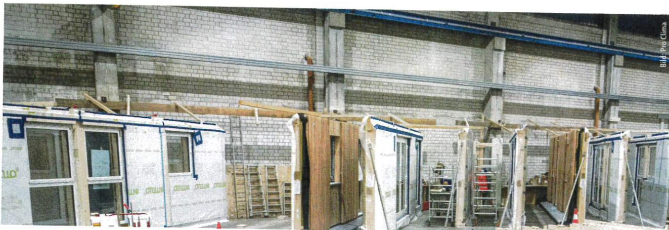
Im Werk des Holzbauunternehmens: Hier werden die Decken und Wände vorelementiert. Der Vorfertigungsgrad liegt bei diesem Bauprojekt bei etwa 80 Prozent. Auch Durchdringungen für Lüftungsanlagen und Gerüstanker können werkseitig mit Luftdichtheitsmanschetten eingedichtet werden.
