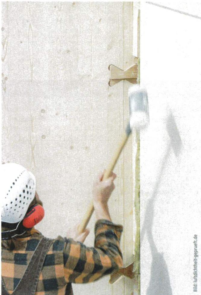
Holzverbindung von Brettsperrholz mit Brettschichtholz: Bei diesen Schwalbenschwanzverbindern aus Holz ist die präzise Vorfertigung entscheidend.
