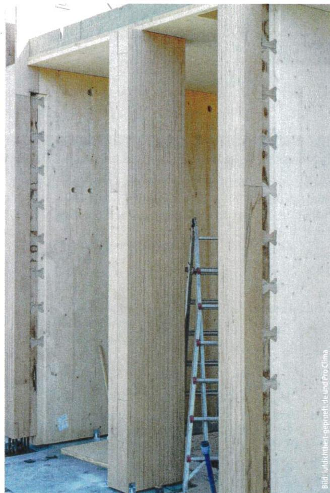
Holz-Holz-Verbindungen, Buchenfurnierschichtholz als Träger und aussteifende Brettsperrholzwände im Erdgeschoss.
