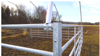
foto 4 nasazení a upevnění oblouků
