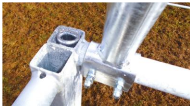
foto 5 nasazení a upevnění oblouků
