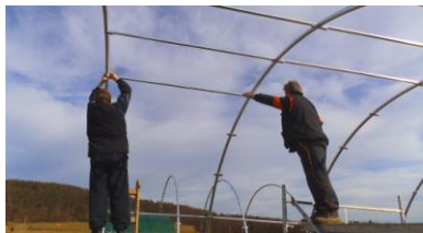
foto 7 montáž příčných trubek
