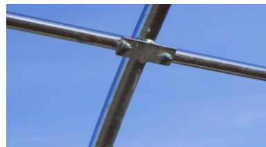
foto 9 montáž příčných trubek
