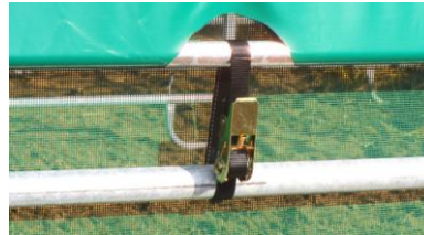
foto 12 upevnění plachty pomocí ráčen
