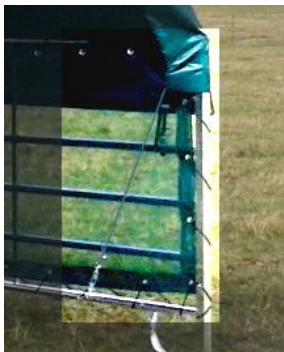
Foto 13 napnutí ocelového lanka na přední části plachty Foto 14 napnutí ocelového lanka na zadní části plachty
