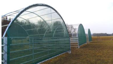
foto 10 upevnění zadní sítě
