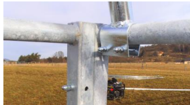
foto 3 spojení spodní konstrukce šrouby
