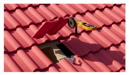
Bitte beachten Sie bei der Bearbeitung von Dachziegeln die anerkannten Regeln des Dachdeckerhandwerks. Eine Bearbeitung von Dachziegeln führt regelmäßig zum Verlust der Gewährleistung und ggf. einer Garantie für die Dacheindeckung. Eine unsachgemäße Bearbeitung von Dachziegeln kann zur Undichtigkeit des Daches führen und erhebliche Schäden verursachen.
