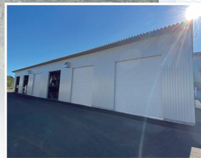
<リサイクル集積倉庫 2022年3月竣工>
