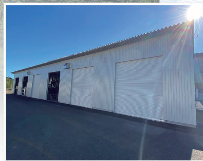
<リサイクル集積倉庫 2022年3月竣工>
