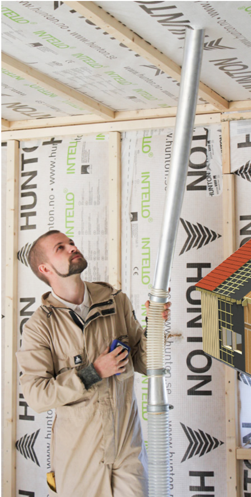
Illustrationen visar vägg blåsiserad med Nativo® träfiberisolering.
