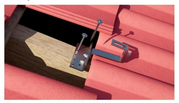
Bitte achten Sie darauf, dass zwischen dem Bügel des Dachhakens und den darunterund darüberliegenden Dachziegeln ein Abstand von mindestens 6mm eingehalten wird, um eine elastische Verformung des Hakens zu ermöglichen.
