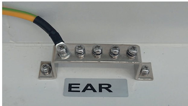
Figura 3: Morsettiere equipotenziale terra
