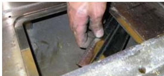
7. Dra ur förslutningshöljet till rökgaskanalen ur dess högra fäste.
