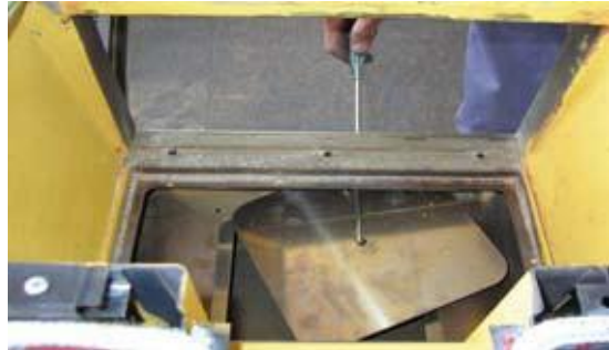
6. Ta bort den undre täckplåten/plåtarna till rökgaspassagen; K80 är utrustad med två plattor
