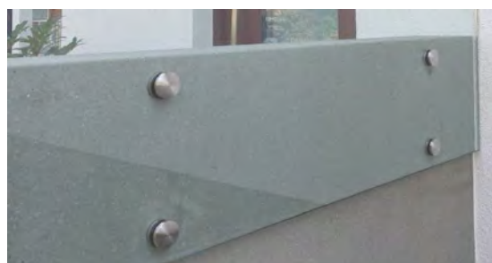
Seitenschutz Befestigung mit Punkthalter
