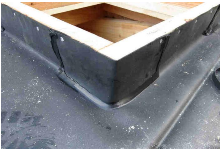
Kanterne af det påsatte gummi forsegles med fugemasse
