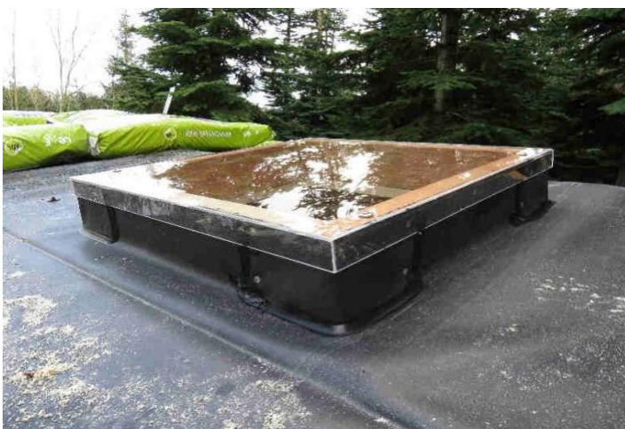
Gummidugen skæres af glat med overkant ramme. Ruden monteres med de 4 skruer med gummiskiver.
