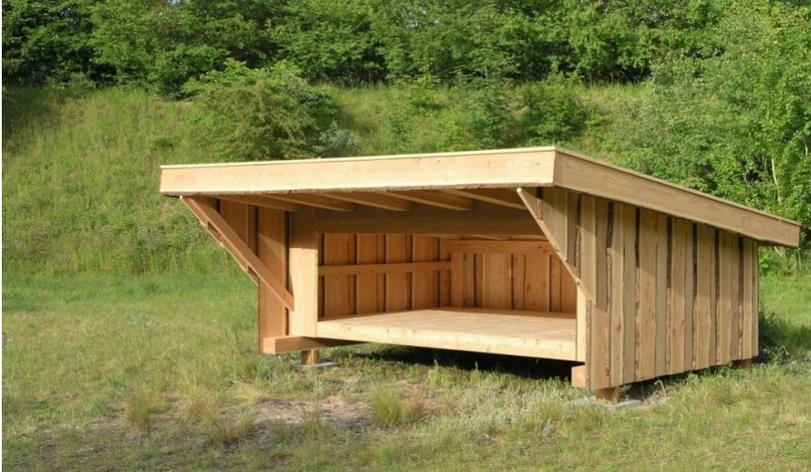
Kyndby Huse v/ Fredrikssund, 3,5 x 2,5 meter indv.
