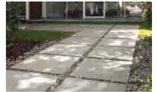
Posa su ghiaia . Installation onto gravel
