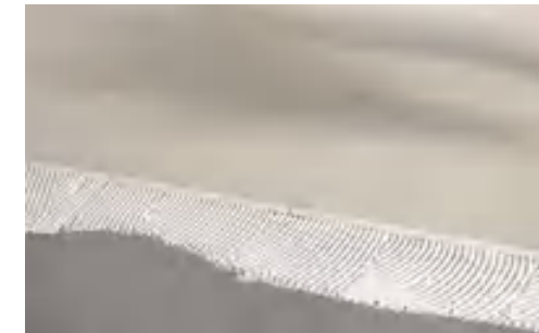
Posa tradizionale con colla . Traditional adhesive installation
