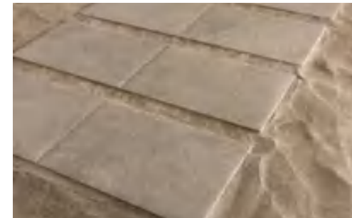
Posa su sabbia . Installation onto sand
