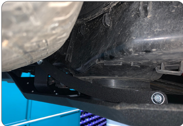
Abb. 8: Montage der Versteifung / mounting of the stiffener
