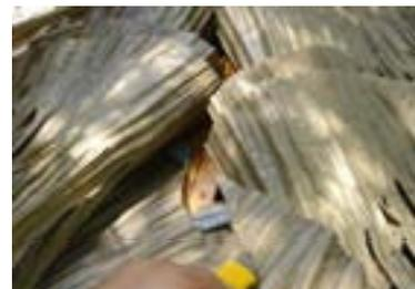
Dans les coins, couper la feuille à gauche du coin, en angle à partir du rail afin de suivre le travers de coin jusqu'au rail plus bas.
