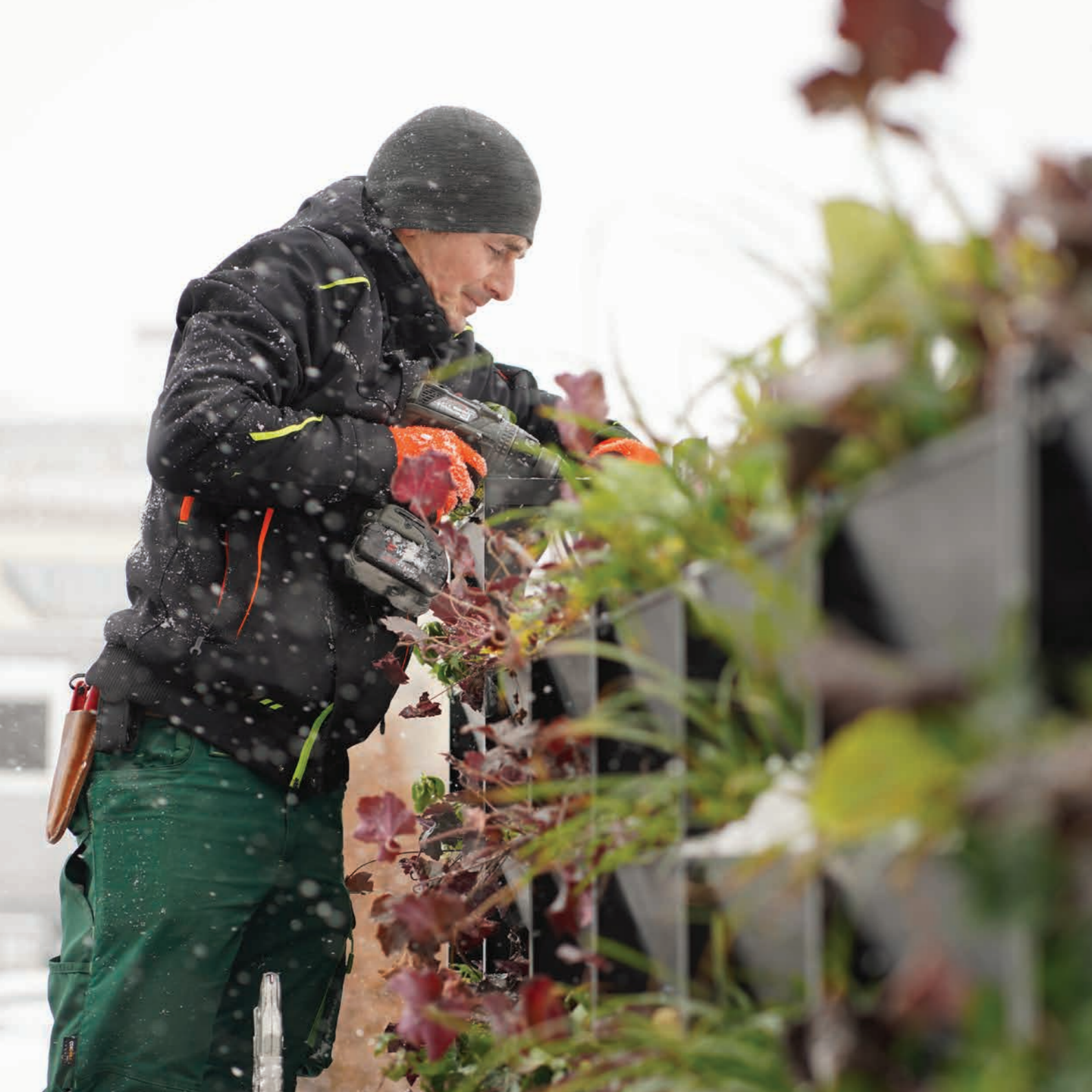
Abbildung links: Montage der PlantBox in einem Lichthof. Hier wurden die Module fertig bepflanzt verbaut.
