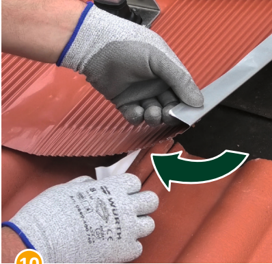
10 Schutzfolie des Klebestreifens auf der Unterseite der Alpha-Platte komplett abziehen
