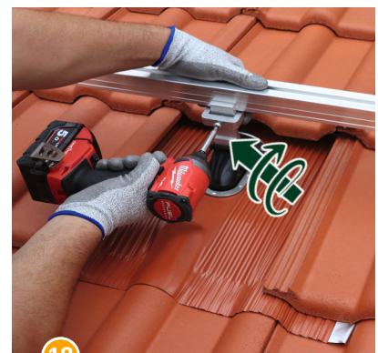
18 ...und die Position durch Anziehen der Schraube fixieren (15 Nm \pm 0,5 Nm)
