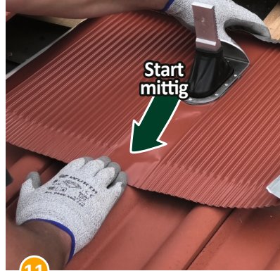
11 Von der Mitte an beginnend nach außen fest und formschlüssig andrücken....
