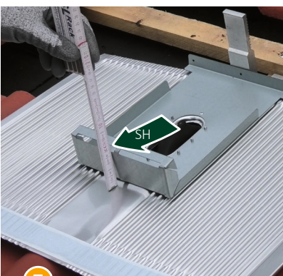
7 Dachplattenhöhe (DH) = Stützblechhöhe (SH)
