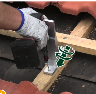
4 Konsolle befestigen: Position durch Anziehen der Schraube fixieren (8 Nm \pm 0,5 Nm)
