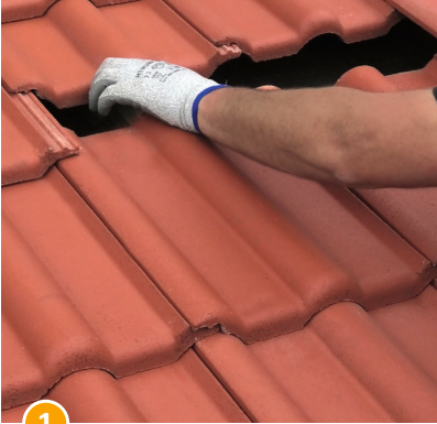
1 Dacheindeckung im Montagebereich aufdecken und die äußeren Dachplatten....
