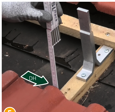
5 Ermitteln der auszugleichenden Dachplattenhöhe (DH)
