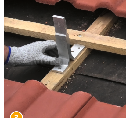
3 Konsolle mit der langen Seite an die Dachlatte heranschieben (Dachlatte dient als Orientierungshilfe)
