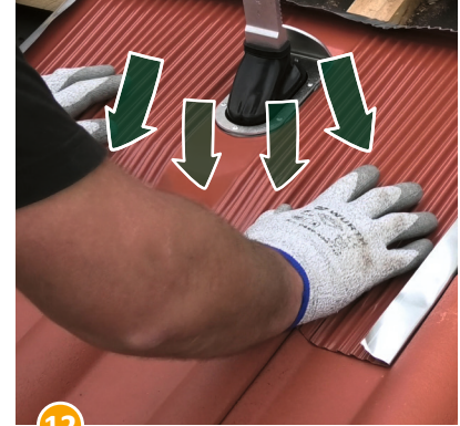
12 ...dabei wieder darauf achten, dass sich im mittleren und oberen Bereich keine Wassersäcke bilden
