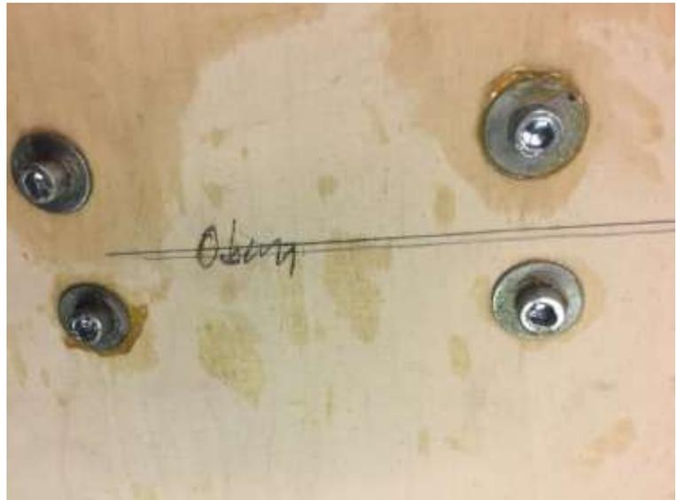
Bild zeigt Verschraubung. Schön ist das Fett zu sehen, welches auch unter der U-Scheibe liegt und hervorquillt. Damit ist eine Anhaftung ausgeschlossen.
