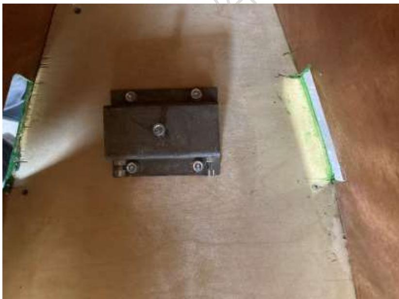
*Achshalter montiert (Bild zeigt vorn)*
