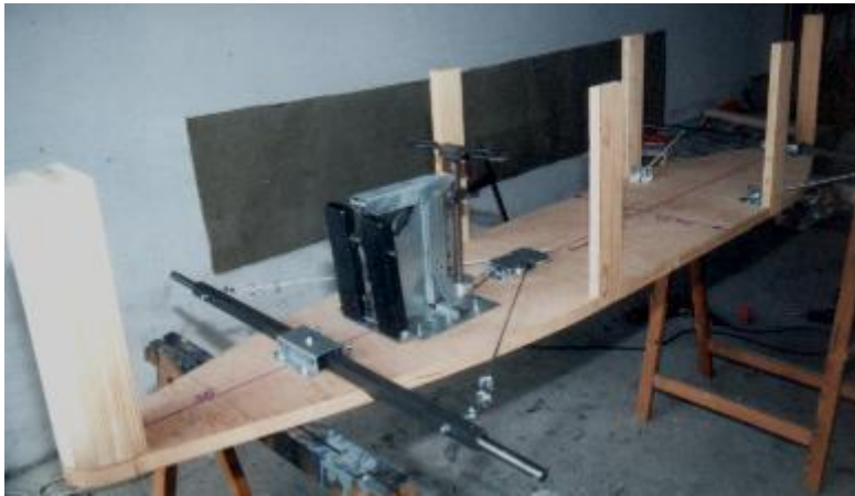
Einbau der Seitenspannen
