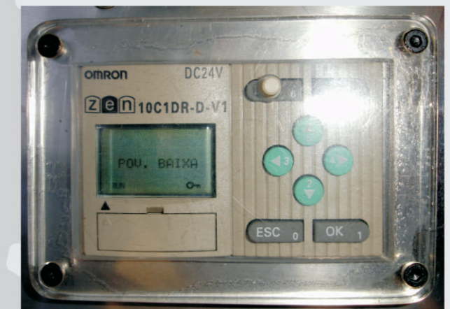
Controle Lógico Programável (CLP) que comanda as operações.
