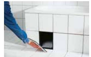
Fliesenrasterplatte mit aufgeklebten Fliesen einsetzen und verfugen.
