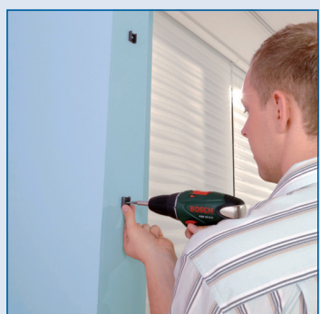
Fixierung der Klips (im Lieferumfang der Falttür enthalten).
