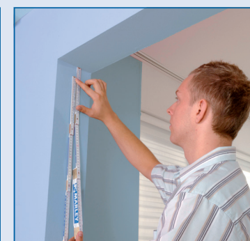
Ausmessen der Türöffnung (Breite und Höhe).
