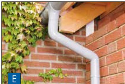
Die Befestigung der Rohre erfolgt mit Rohrschellen, die an der Hauswand mit Dübeln fixiert werden. Dabei wird zwischen der Anwendung als „Festschelle“ und „Losschelle“ unterschieden.
