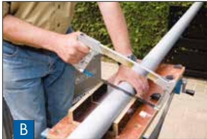
Marley Fallrohre lassen sich einfach und schnell mit einer feinzahnigen Säge trennen. Tipp: Um einen geraden Schnitt zu erhalten, sollten Sie eine Gehrungslade verwenden.
