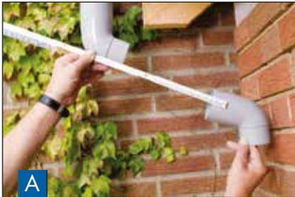
Auf den Stutzen einen Bogen aufstecken und den Abstand zum Gegenbogen messen. Dabei die Einstecktiefe von 4 cm und den Abstand zur Hauswand berücksichtigen. Bei schmalen Dachüberständen werden 2 Bögen mit dem Bogenverbinder direkt verbunden.
