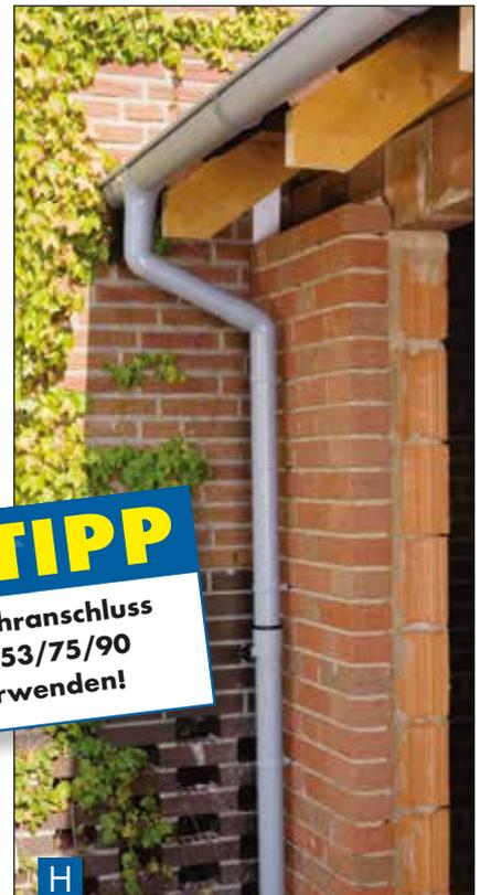
Fallrohre werden mit einer separaten Muffe verbunden. Das Fallrohr-Ende wird mit einem Marley KG-Rohr zum Regenwasserkanal geführt oder es endet in einem Regenwasser-Sickerschacht.
