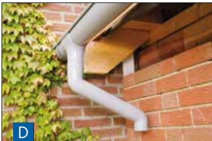
Die Einzelteile des Fallrohrsystems werden einfach zusammengesteckt. Wegen der Einstecktiefe der Formteile werden keine Dichtungen benötigt.
