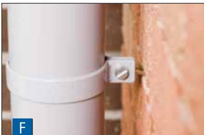
Mit der Anwendung als „Festschelle“ wird das Fallrohr am oberen Ende gesichert. Dabei wird nur die Ringschraube zwischen die Laschen der Rohrschelle montiert. Dadurch kann das Fallrohr an dieser Stelle fest fixiert werden. Abstand der Schellen: 2,00 bis 2,50 m.
