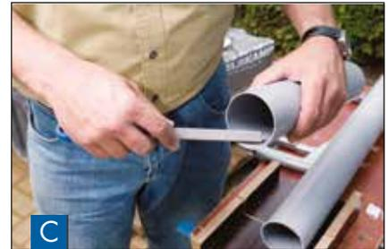
Die Schnitt-Enden des Fallrohrs sauber entgraten, besonders beim Einbau eines Marley Regensammlers kann dadurch die Auffangleistung erheblich gesteigert werden.
