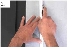
Die Abmaße der Attikaabwicklung auf der rückseitigen Schutzfolie mittels Gliedermaßstab und Cutter vorsichtig auf die Schutzfolie übertragen – siehe Abbildung unten.
