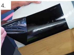
Abschnittsweise (von Punkt a bis d) rückseitige Schutzfolie entfernen und mit dem Baukörper verkleben sowie mit einer Andrückrolle in die Ecke einarbeiten.
