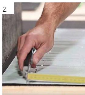
Die Abmaße der Attikaabwicklung auf der rückseitigen Schutzfolie mittels Gliedermaßstab und Cutter vorsichtig auf die Schutzfolie übertragen – siehe Abbildung unten.
