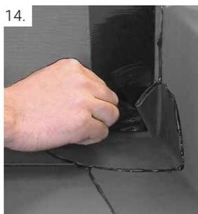
Schutzfolie im Bereich der Quetschfalte entfernen und diese mit Heißluft verschweißen.
