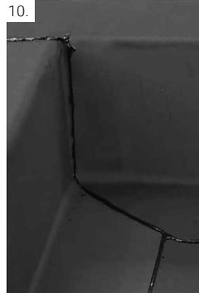
Gehrungsschnitt im Bereich der Dachfläche durchführen und anschließend den zweiten Anschlussstreifen verschweißen.
