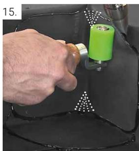
Formteil (Zunge) zunächst in den Eckbereichen (oben und unten) überdehnen (siehe Schraffierung). Anschließend die Zunge über die Quetschfalte im Abstand von 3 mm über der Dachdichtungsbahn platzieren und vollflächig verschweißen.
