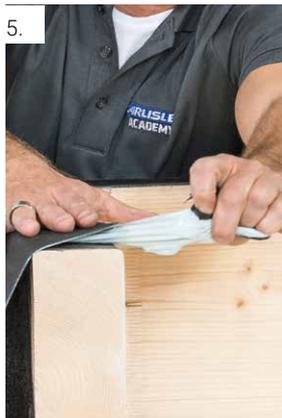
5. Rückseitige Schutzfolie abschnittsweise (von Bereich a bis d) entfernen und Dachbahn mit Attika verkleben.
