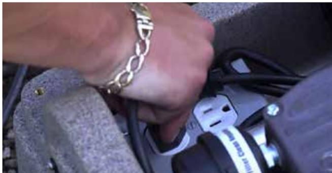
**Systèmes PS10:** Branchez le compresseur et le ventilateur de refroidissement dans la prise de contrôle d'alimentation à l'intérieur de l'armoire (Fig. 1). Branchez le cordon d'alimentation de l'armoire dans une prise de courant GFCI.
