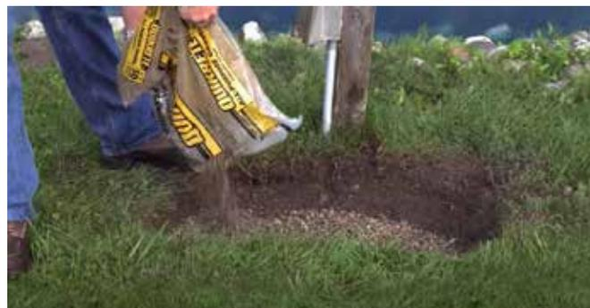
2. Déplacez l'armoire et retirez le gazon de la zone, en remplissant avec une petite pierre ou de gravier. Cela permet d' une base solide pour le cabinet et pour le drainage. Ouvrez l'armoire d'aération en dévissant les 4 vis de pouce lobées . Soulevez délicatement le couvercle de l'armoire et de jeter sur le côté à côté de la base.
