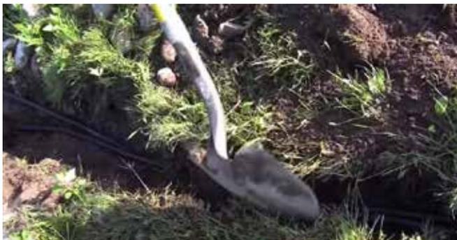
Remblayez la tranchée de la conduite d'air à quelques endroits pour maintenir temporairement la conduite d'air en place jusqu'à ce que l'installation soit terminée.
