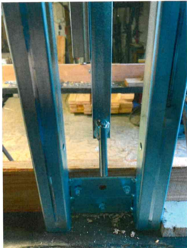
Bild 6 : Gestänge ein setzen
