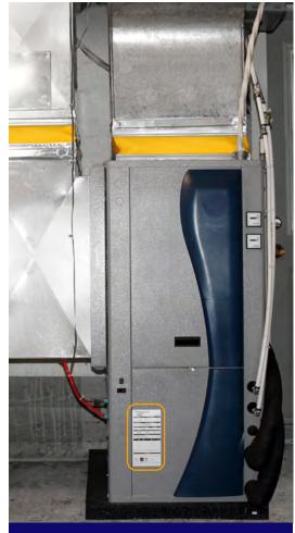
Illustration de l'emplacement de l'étiquette sur l'appareil intérieur d'une thermopompe air-air bibloc (centrale).
