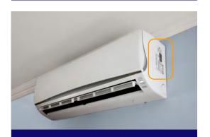
Illustration de l'emplacement de l'étiquette sur l'appareil intérieur d'une thermopompe air-air minibibloc sans conduit (murale). Si l'installation comporte plus d'un appareil intérieur, la photo d'un seul appareil est requise.
