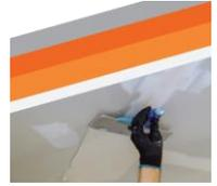
Resanador acrílico ligero flexible base agua, para reparar interiores y exteriores en superficies de concreto, mortero, pastas acrílicas, yeso, aplanados, panel de yeso y madera. De secado rápido, permite ser lijado para nivelar superficies y desvanecer hoyos y grietas pequeñas en muros con o sin acabado. Se aplica en una sola mano y está listo para usarse, no requiere agregar agua ni revolver. Su flexibilidad permite adaptarse a múltiples formas dependiendo de la superficie a resanar.
