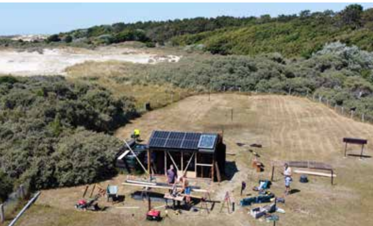
Prachtig weer op de bouwplaats Ringstation Westenschouwen!
