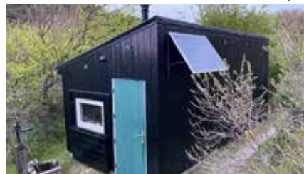
Het oude zonnepaneel is hergebruikt op de zuidwand van de woonhut
