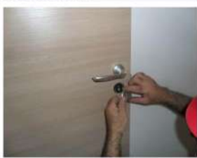
7. Montare la maniglia in dotazione
