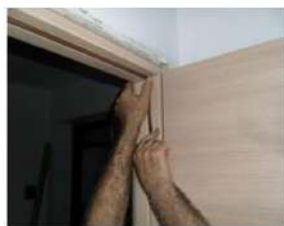
11. Inserire la guarnizione.
