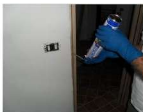
13. Riempire i vuoti attorno al telaio con la schiuma . Maneggiare con cura, poiché questa potrebbe fuoriuscire
