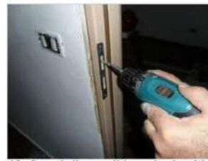
10. Consigliamo di inserire le viti dietro la contro piastra per evitare viti a vista, e per un montaggio più ordinato.
