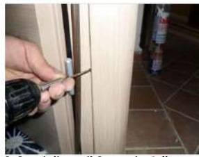
9. Consigliamo il fissaggio della porta al falso telaio inserendo le viti dietro la guarnizione per un montaggio più ordinato.
