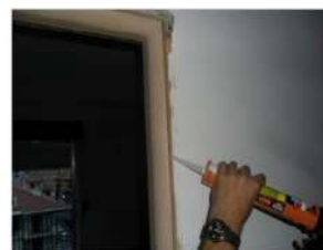
15. Mettere il silicone nell'incastro del coprifilo.
