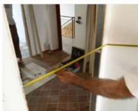
2. Controllare la misura interna del controltaio
