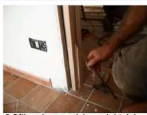
8. Sfilare la guarnizione dal telaio per inserimento viti di fissaggio
