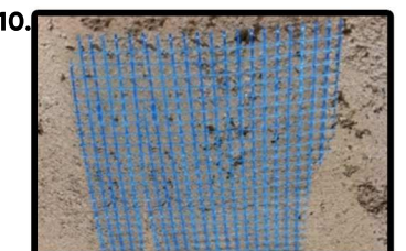
utilizzare anche la rete in poliuretano (in dotazione), accavallando tra la rete metallica e il laterizio.
