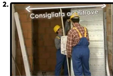
dopo aver assemblato il telaio appoggiarlo alla tramezzatura.
