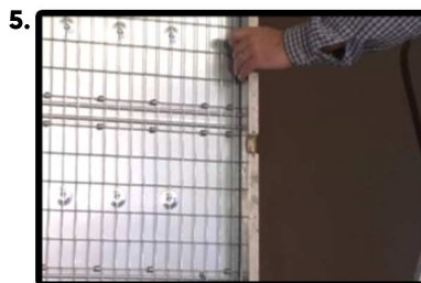
la messa in bolla è basilare.
