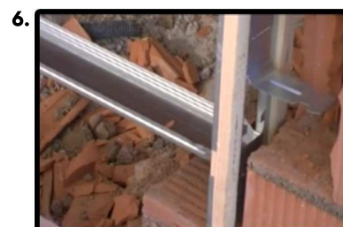
allargare le zanche ricavate nel controtelaio.
