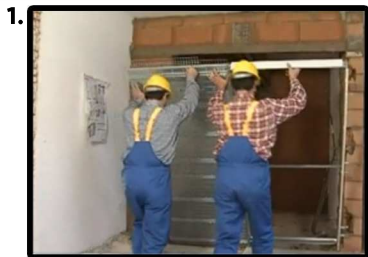
MONTAGGIO su tramezzatura già realizzata
