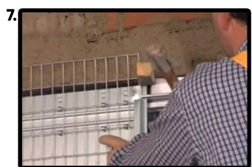
provvedendo a bloccare il controtelaio con dei cunei
