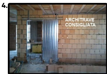
si presti attenzione nella messa in bolla e si abbia l'accortezza di realizzare una architrave superiore.
