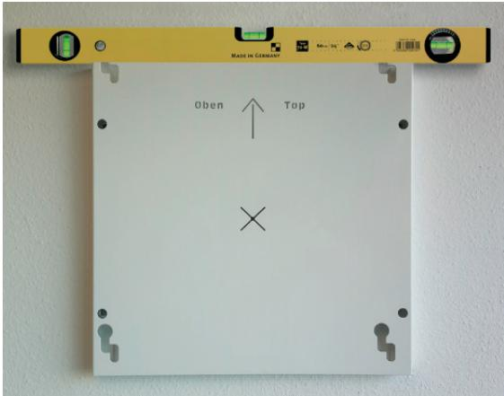
Fixez maintenant l'élément d'accrochage au mur en utilisant les vis incluses (C). Engagez les vis complètement dans les goujons. En cas de mur creux prenez soin d'une fixation solide des vis.
