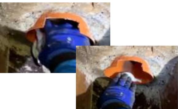
Reinigen des PVC-Rohres mittels Tuchs. Gleitmittel rohinnenseitig auftragen.
