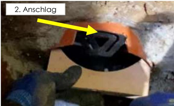
Rückstauklappe mittels Gummihammer und Einbauholz in PVC-Rohr bis zum 2. Anschlag einklopfen. ACHTUNG: Fließrichtung und axiale Ausrichtung beachten.
