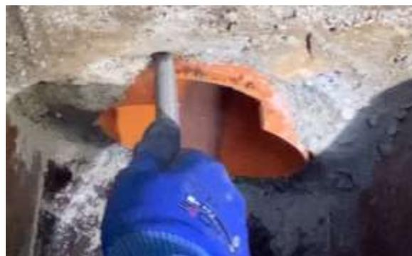
PVC-Rohr mittels Feile entgraten.
