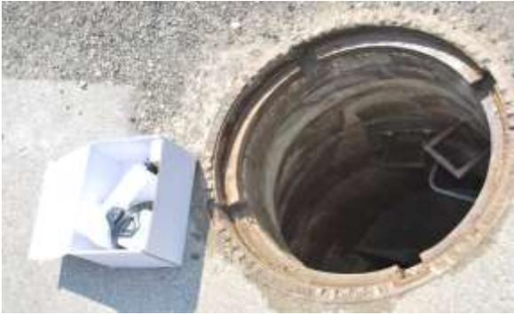
Schachtdeckel samt Unterbau entfernen, offenes Gerinne inspizieren, gegebenenfalls reinigen und grobe Betonkrusten (Überstände) um das PVC-Rohr entfernen.
