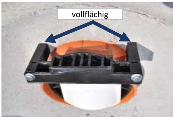
ACHTUNG: der Fixierteil muss Rohr-achsbündig eingebaut sein und die Stege müssen vollflächig am Beton anliegen.
