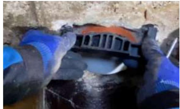
Re-montage der weißen Klappe. Einpassen des Fixierteils: bei Bedarf müssen die Stege gekürzt werden. Anschließend anzeichnen der Bohrlöcher.
