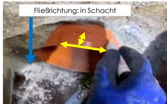
Anzeichnen der Mittelachse und des zu entfernenden Rechteckes (20x80mm). Restabstand zur Wand max. 30mm.
