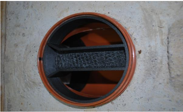
Fixierteil aufsetzen - Nut muss in Feder einrasten install the fixing part, make sure that the notch fits properly
