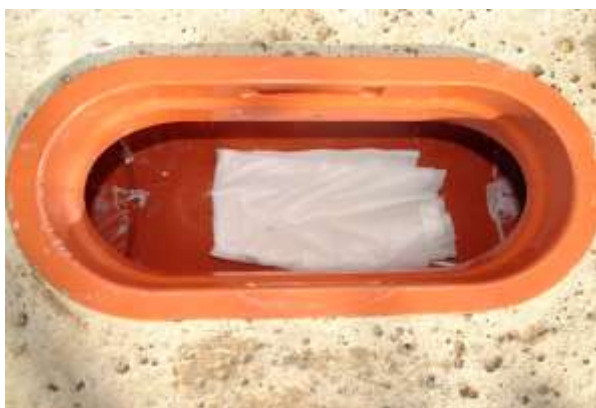
gegebenenfalls mit feiner Stahlwolle und/oder Tuch reinigen
