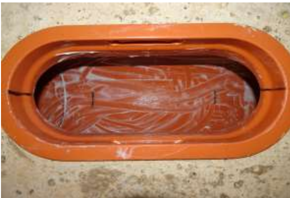
Putzöffnung innen vollflächig mit beigelegten Gleitmittel bestreichen
