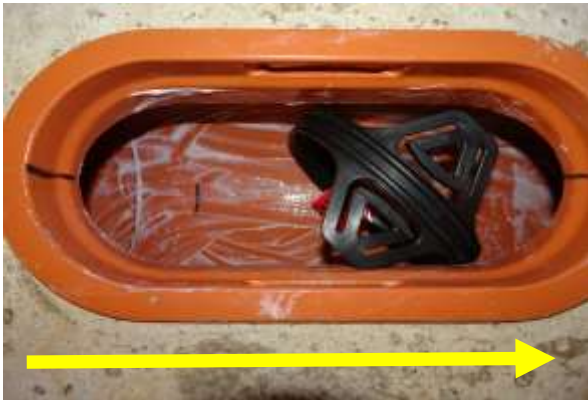
erste Klappe SCHWARZ mit schwarzen Dichtungen einführen
