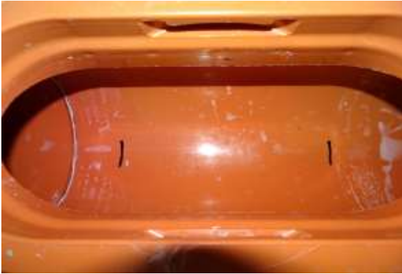
mit Stift die richtige Lage der Klappen anzeichnen
