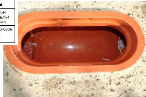
optische Begutachtung des Zustandes im Inneren des Putzstückes
