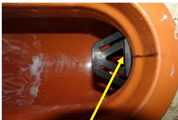
bis zum 2. Anschlag einschlagen Anschlag muss in Achse sein
