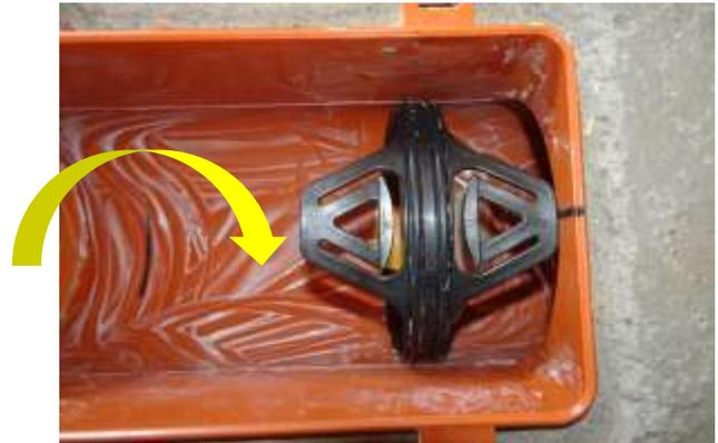
Klappe um 90° drehen und Einbauhilfe richten - Klappe muss in Fließrichtung öffnen
