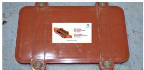
Putzdeckel wieder aufsetzen und verschließen - Hinweisschild befestigen
