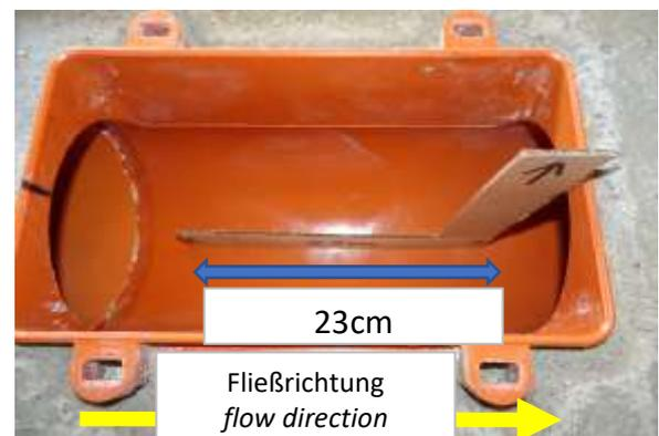
Montagewinkel in Putzöffnung einführen und mit Stift die richtige Lage der Klappen anzeichnen
