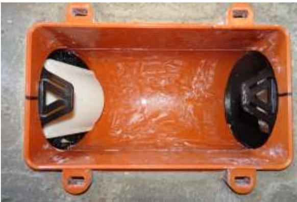
Klappe bis zum 2. Anschlag einklopfen, Klappe muss in Fließrichtung öffnen
