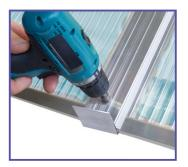
Nacheinander immer zwei Platten auflegen, ausrichten und fixieren. Profiloberteile Rand und Mitte auflegen und mit Scobalit Edelstahlschrauben Metall (6,3 x 32 mm) oder Bohrschrauben (5,5 x34 mm) mit dem Unterteilen verschrauben. Fortfahren bis zur letzten Platte. Diese dann einmessen, ggf. zuschneiden und mit Randprofil montieren.
