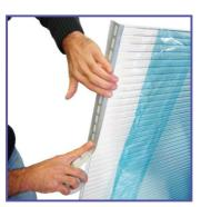
Bringen Sie das passende Kantenverschlussband am Ende der Platte an. Es verhindert das Eindringen von Staub, Schmutz und Insekten. Die Membranenversion lässt gleichzeitig die Lüftung der Hohlkammern zu.
