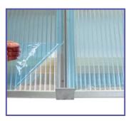
Legen Sie die Platte auf und richten Sie winkelgerecht aus. Plattenabstand 28 mm. Die gekennzeichnete Schutzfolie nach oben - UV-Schutz!
