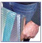
Montieren Sie dann an der Unterseite (Traufe) die Alu-U-Abschlussprofile mit Tropfnase nach unten. Die Schutzfolie wird dabei nur soweit entfernt wie es zur Befestigung nötig ist.
