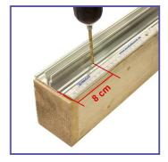
Profilunterteile im Abstand von 35 cm links und rechts vom Mittelsteg im Wechsel vorbohren (Ø 5 mm). Der Abstand der ersten Bohrung zur vorderen Kante beträgt 8 cm.
