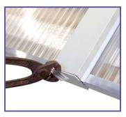
Nun kann der Abschluss- und Haltewinkel je nach Höhe des Profiles (mit oder ohne Zierklemmdeckel) mit einer Zange abgebrochen werden.
