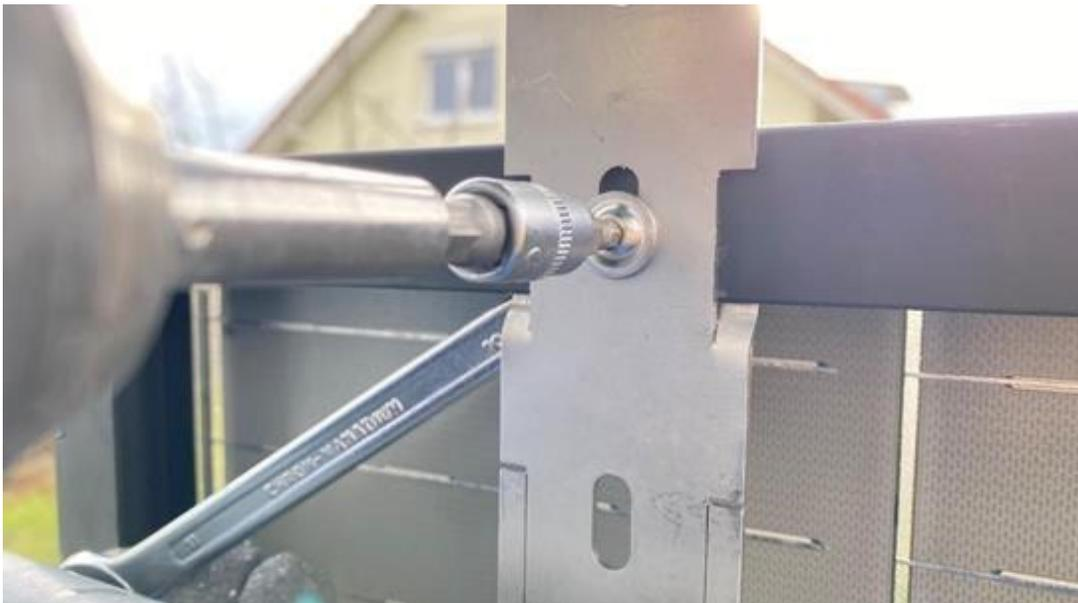
*Abbildung 16/ Anziehen der kurzen Schrauben*
