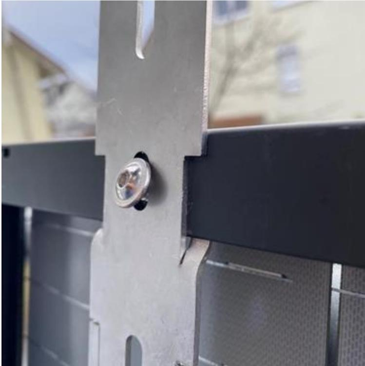
*Abbildung 5 / Lose montierte Schraube M6 kurz.*
