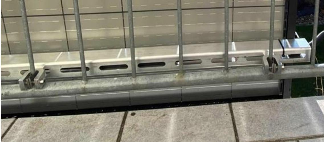
*Abbildung 10/Montage der Schiene an der Spezialklemme*
