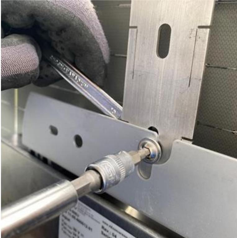
*Abbildung 6/Schrauben Sie den Wechselrichter an die SOLARHOOK-Montagehalterung.*
