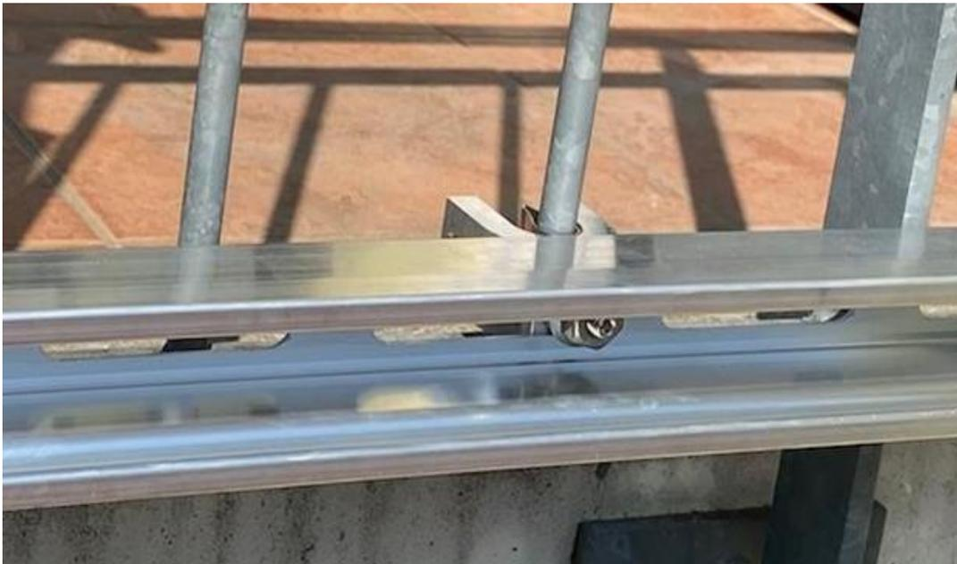
*Abbildung 11/Montageschiene und Spezialklemme von außen*
