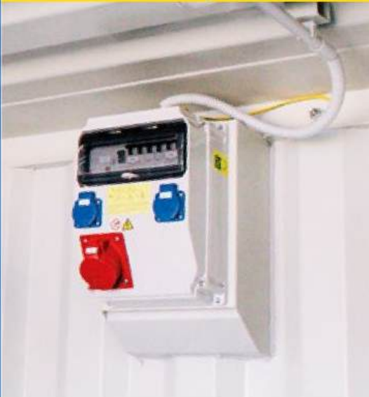
Verteilerkasten mit integrierten Steckdosen
