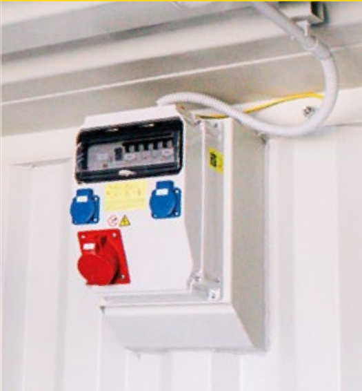
Verteilerkasten mit integrierten Steckdosen
