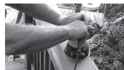
PONCAGE AVEC UN PAPIER ABRASIF DE CALIBRE 60-80
