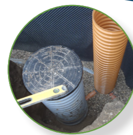
ATZ A/S installerar 2017-20 70 st. Ø425 mm dräneringspumpstationer i bostadsföreningen AST i Brønshøj utanför Köpenhamn.
